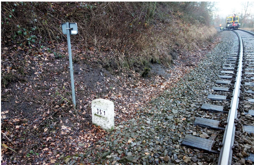
Foto 7: Pohled na část zářezu v km 35,100 - 35,150 (u příkopu a nad příkopem patrné navážky odpadu z čištění lože)
